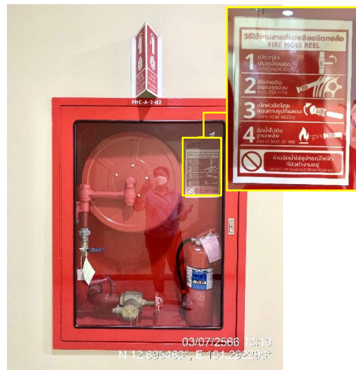
ถังดับเพลิง และตู้เก็บสายฉีดน้ำดับเพลิง พร้อมวิธีการใช้งาน
