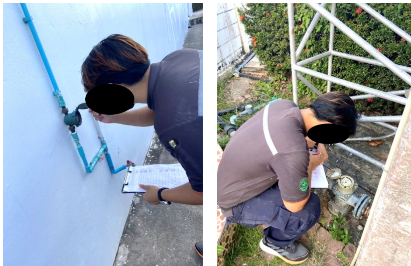
รูปที่ 2-36 การตรวจเช็คมิเตอร์น้ำและจุดบันทึกปริมาณการใช้น้ำเป็นประจำ
