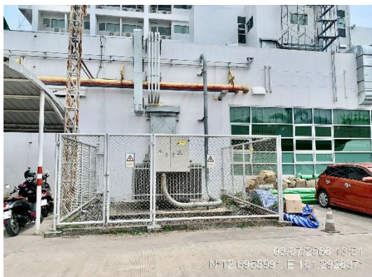
รูปที่ 2-31 การตรวจสอบหม้อแปลง ขนาด 2,000 KVA ของโครงการ
