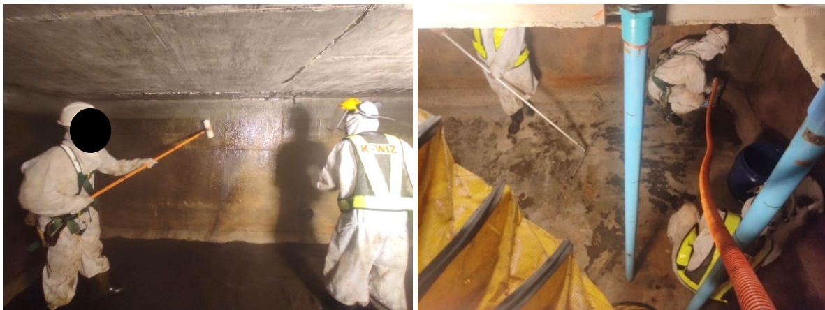
รูปที่ 2-20 การล้างทำความสะอาดบ่อบักน้ำ
