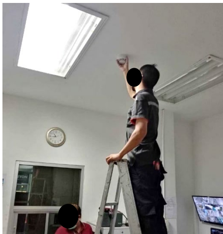
รูปที่ 2-42 การตรวจสอบดูแลรักษาอุปกรณ์ป้องกัน/เตือนภัยอัคคีภัย
