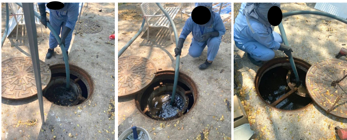
รูปที่ 2-8 เทศบาลตำบลเชิงเนินเข้ามาสูบตะกอนระบบบำบัดน้ำเสีย
