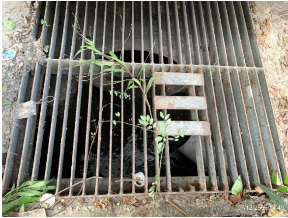
รูปที่ 2-16 ตะแกรงดักตะกอนที่ระบายน้ำ
