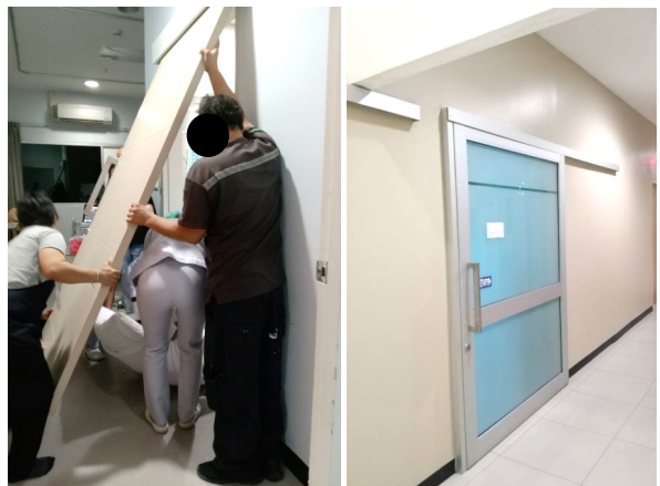
การตรวจสอบและแก้ไขประตู ลดการสูญเสียความเย็นจากเครื่องปรับอากาศ
