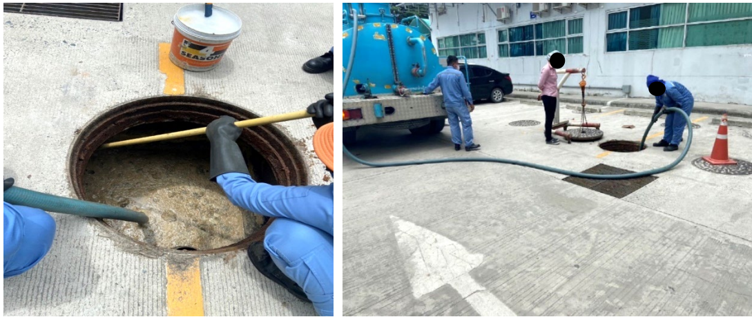
รูปที่ 2-19 รถดูดไขมันเข้ามาจัดเก็บถังดักไขมัน
