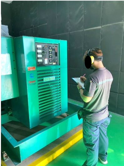
เครื่องกำเนิดไฟฟ้าฉุกเฉิน
