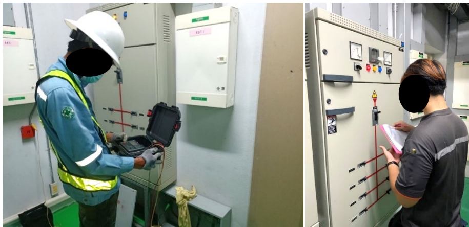
รูปที่ 2-35 การตรวจเช็คมิเตอร์ไฟฟ้า
