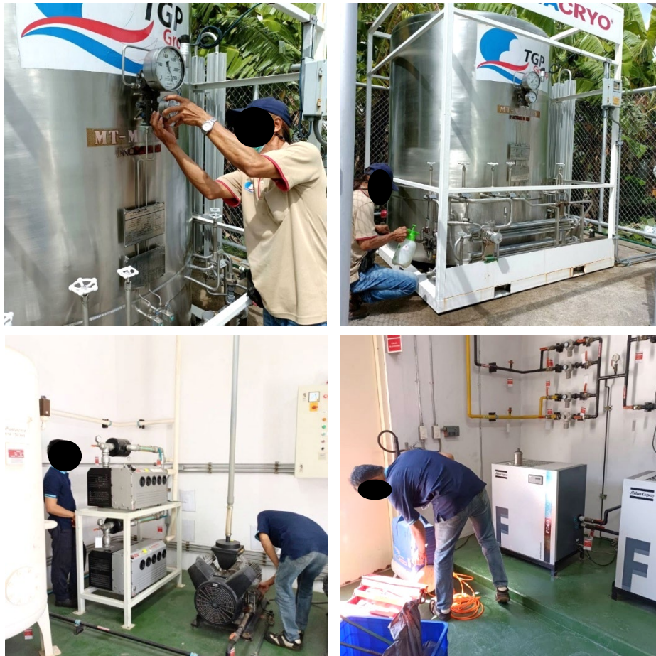
รูปที่ 2-45 การตรวจสอบดูแลระบบออกซิเจนเหลว 1 ครั้ง/ปี และระบบแก๊สทางการแพทย์
