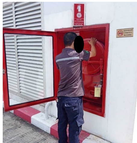
รูปที่ 2-42 การตรวจสอบดูแลรักษาอุปกรณ์ป้องกัน/เตือนภัยอัคคีภัย
