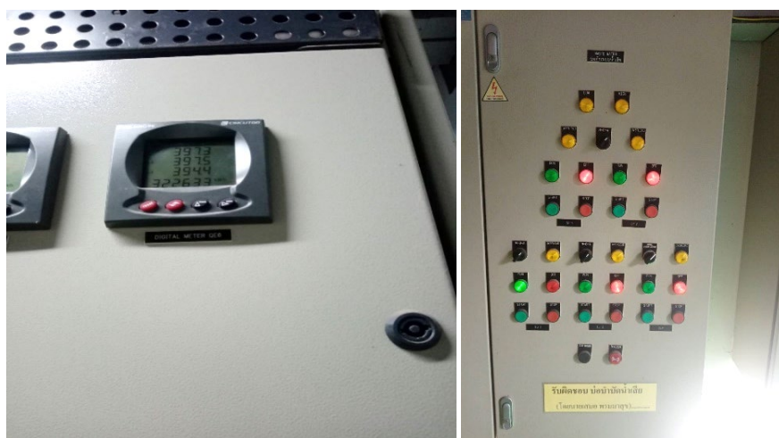
รูปที่ 2-21 มิเตอร์ไฟฟ้าสำหรับระบบบำบัดน้ำเสียของโครงการ
